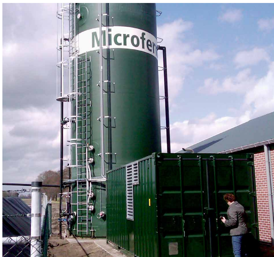
Eerste monovergister met WKK in Langeveen (Microferm).
