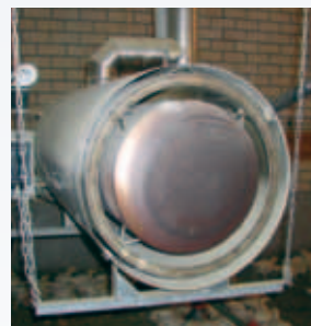
Foto 3: Warmtekanon met afvoer van rookgassen naar de buitenlucht: alternatief voor het klassieke kanon
