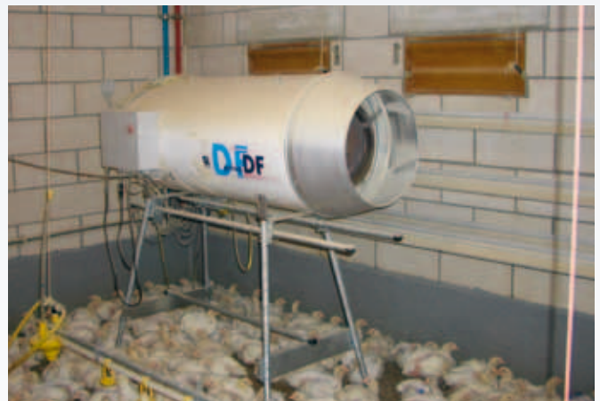
Foto 1: Het klassieke warmtekanon geeft extra CO 2 in de stal
