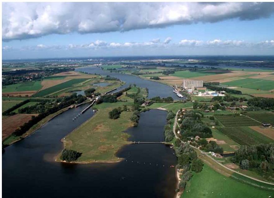
Figuur 12.3 De Afgedamde Maas. Rechts op het eiland het innamestation van drinkwaterbedrijf Dunea, Bron: Dunea.
