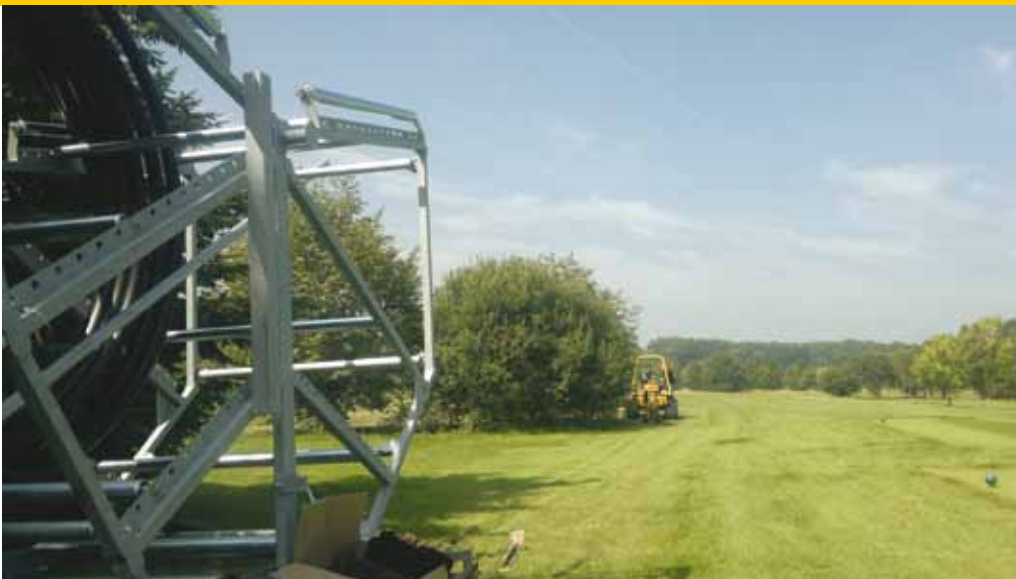
Aanleg irrigatie door VBS/Vermeer.
