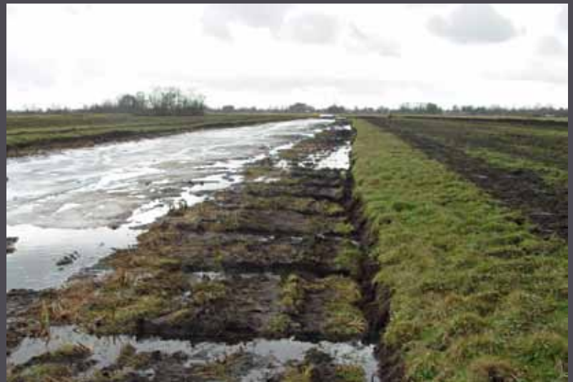
Aanleg natuurvriendelijke oevers in 2005.
