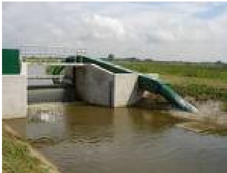
Figuur 4 Hevelvispassage op een stuw in de Hertogswetering in het Brabantse Berghem
