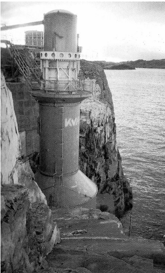
Afbeelding 2.18 OWC-installatie in Noorwegen
