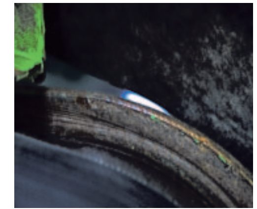
▲ Groeven in het plaatwerk rondom de rollen maken duidelijk dat de afvoerband scheef heeft gelopen.
