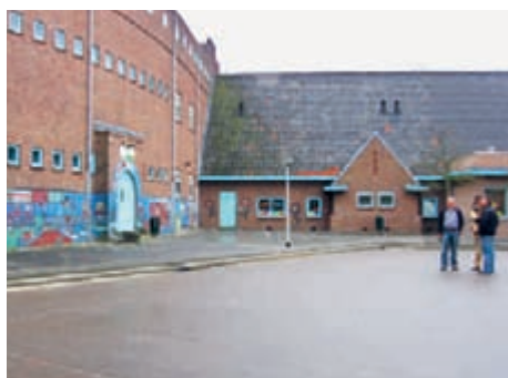
Foto boven: het eerste nieuwe groene schoolplein in Rotterdam. Onder: de oorspronkelijke situatie.
