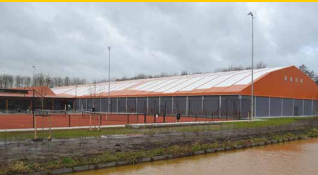
Het dak en de spanten zijn erop berekend om een forse sneeuwlaag dragen.
