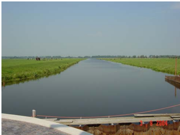
Figuur 2.2 Uitzicht vanaf het gemaal 'Krimpenerwaard'.
