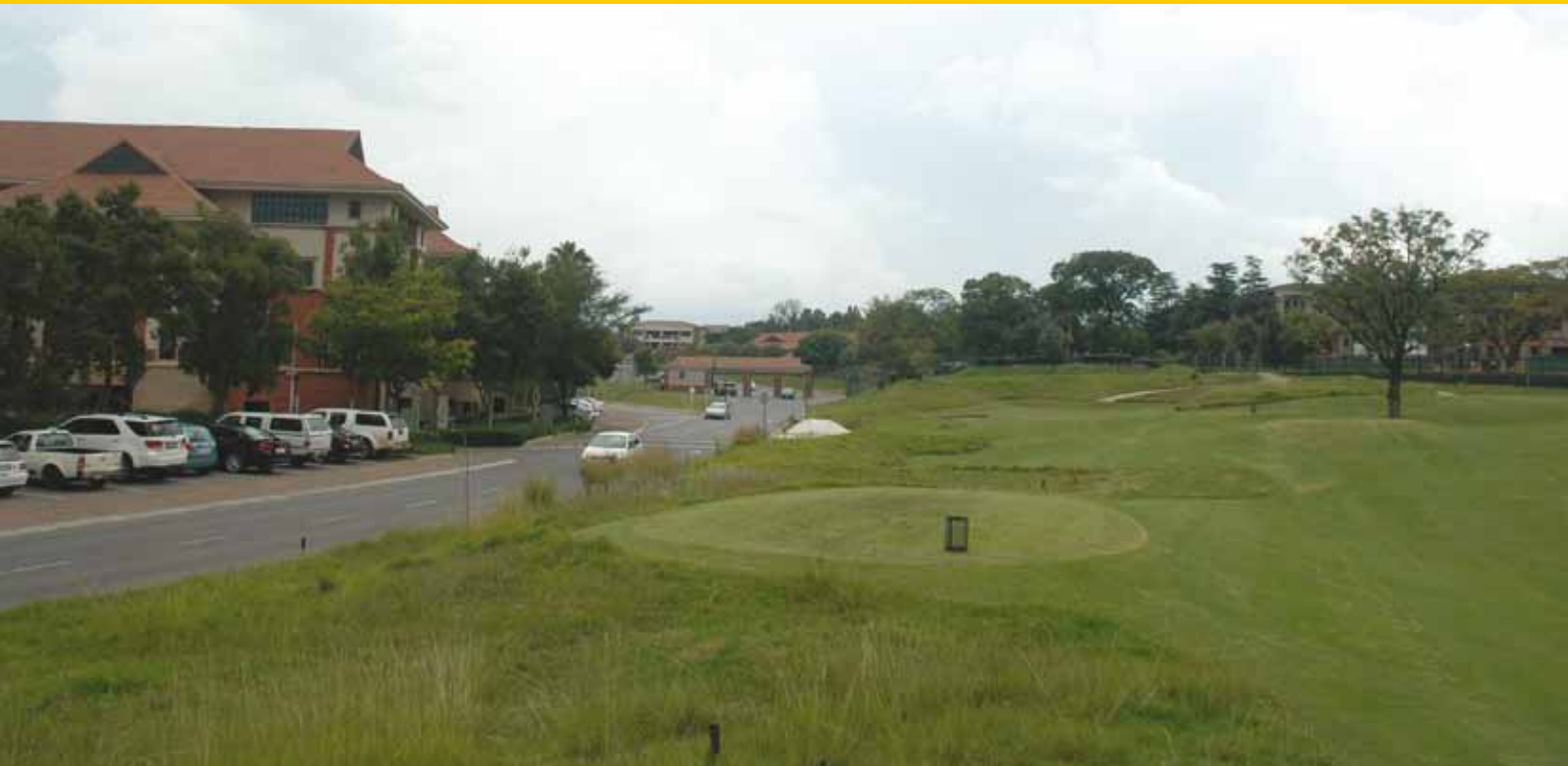
De uitlopers van de golfbaan liggen op het dak van de ondergrondse parkeergarage.
