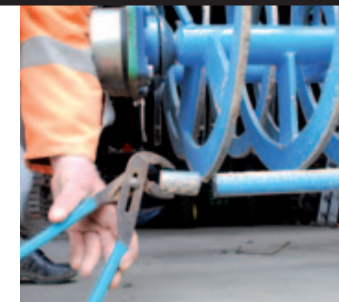
▲ Omdat de egalisatiebuis de grond net iets te ver buiten de machine bracht, is er aan beide zijden 5 cm afgeslepen.
