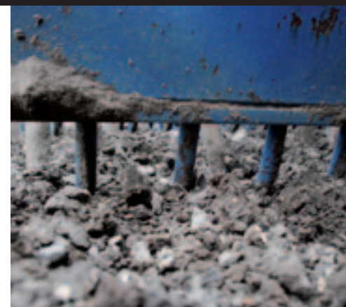
▲ De egalisatieplaat heeft 10 cm lange tanden om geen overtollige grond mee te slepen.
