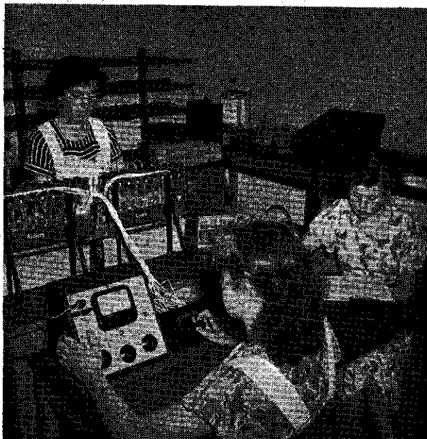
Afb. 4. Electrometrisch bepalen van de pH.
