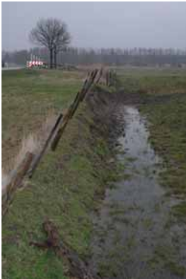
Barrière met een laag, schuin geplaatst hekwerk, tussen het Oostvaardersveld en de Praamweg, die voorkomt dat Koniks de weg opgaan
