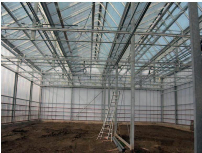
Figuur 3.7. Februari 2011. Nadat de kas glasdicht is gemaakt kunnen de installaties worden aangebracht.
