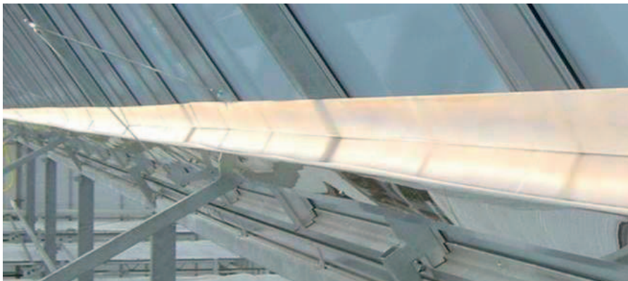
Figuur 4.7. Schaduwbanen door de glasroeden en tegelrandjes in de lenzen op de collector.
