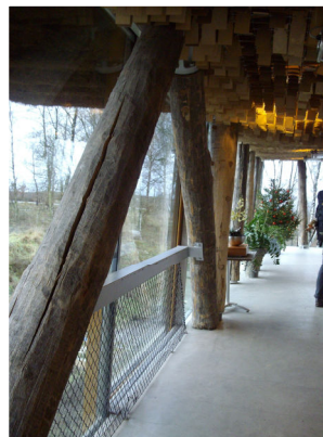
Afb. 6 gebouw “de Postbank”.
