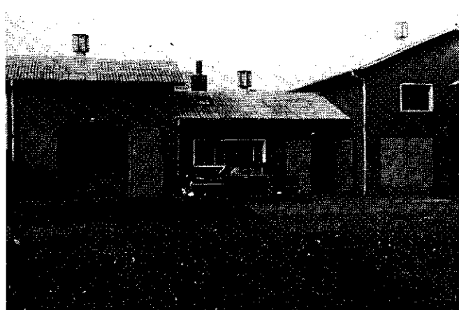
Fig. 4. Dano-installatie in Rødovre In gebouwtje links: uitmondning van de silo, waar het grove vuil kan worden verwijderd Dano-installation at Rødovre In shed at the left: outlet of the "silo". Here the coarse refuse can be removed
