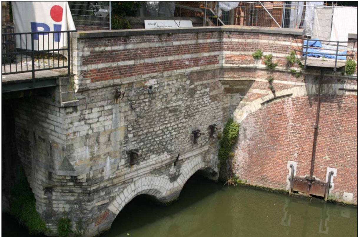
Verdeelpunt tussen de Dijle en de Melaan bij de molen op de Dijle. De boog waardoor het water naar de Melaan stroomde is in de twintigste eeuw dichtgemetseld.
