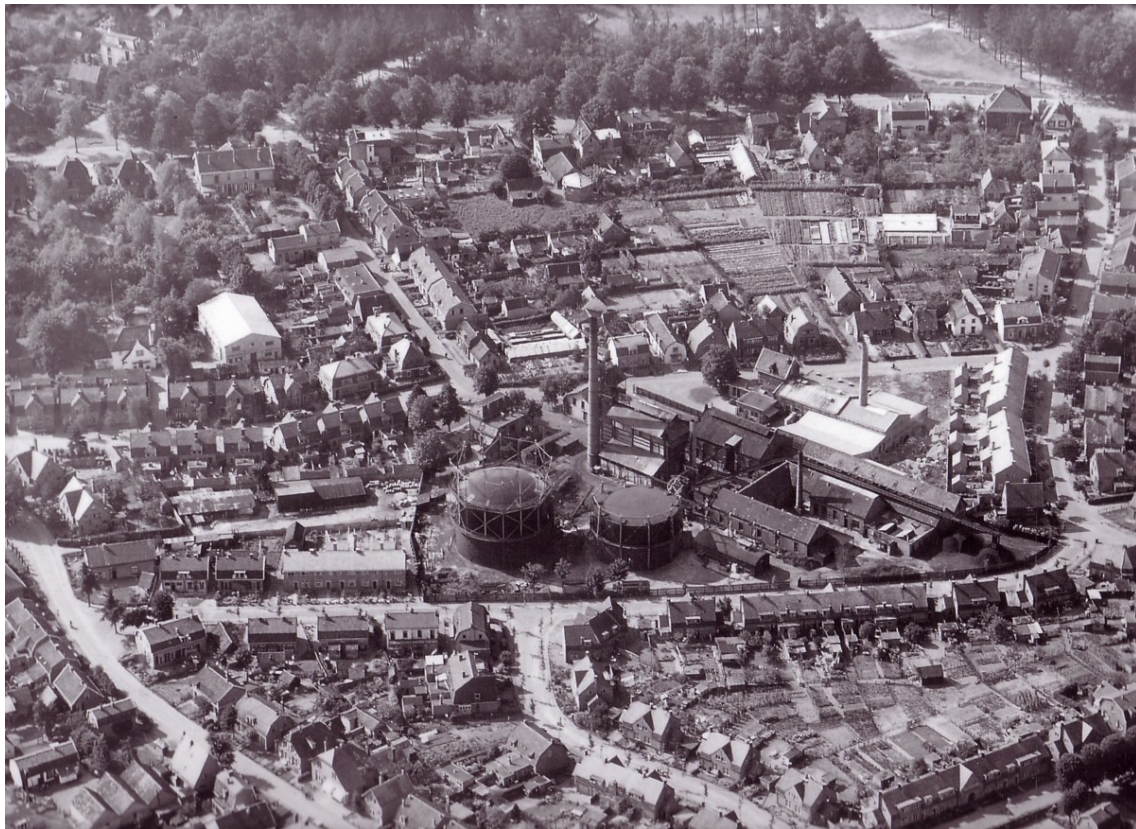
22 Circa 1949, Luchtfoto gasfabriek met Gaslaan. (KLM Aerocarto) Boven: uitsnede van Villa Evergreen en Villa Dennenhorst met tuin en koetshuis
