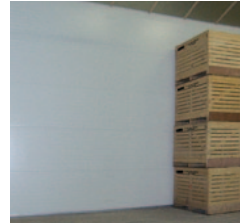
▲ Met de spanten buiten ontstaat aan de binnenzijde een volledig vlakke koelcel.
