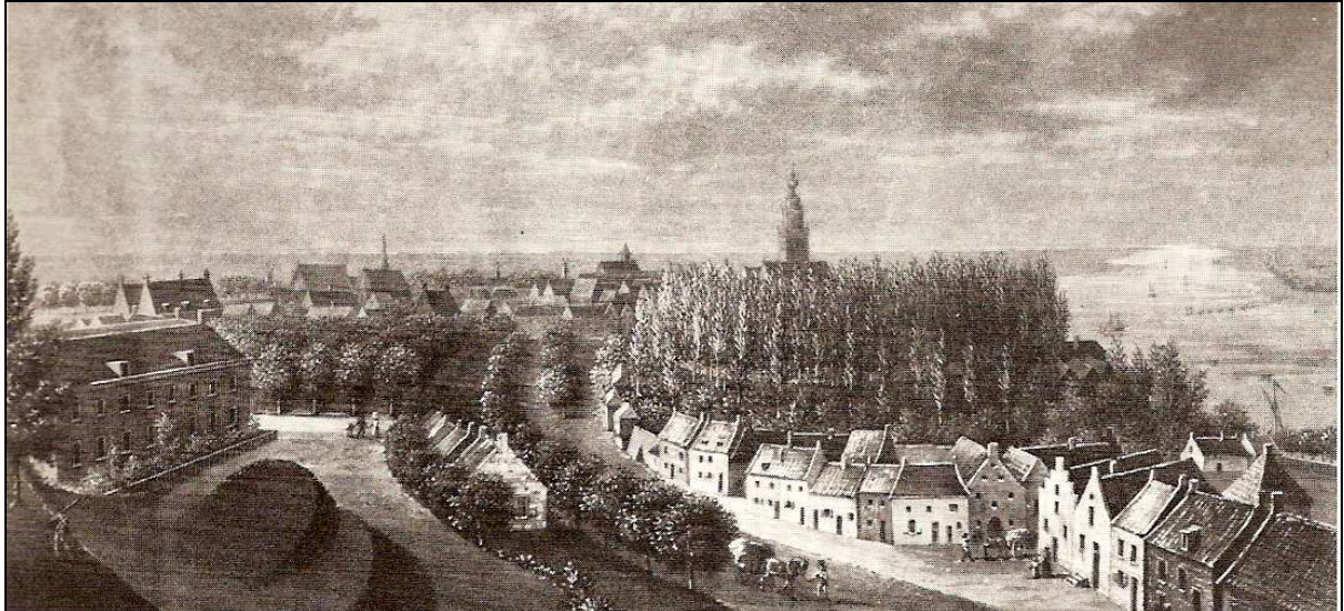
Nijmegen vanaf het plat der Belvédère (1832) van Anton baron de Howen, gravure van Hendrik Willem Hoogkamer. Het Valkhofpark torent als een groen plateau boven de bebouwing van de Voerstraat en de Rozemarijngas uit. Links op de gravure staat het landhuis op het Kelfkensbosch.
