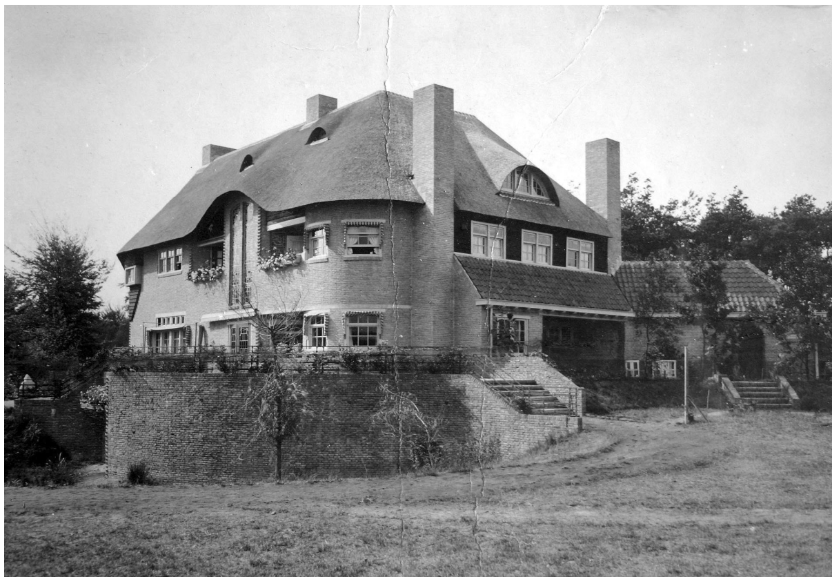
De achtertuin gezien vanuit het zuidoosten, ca 1924
