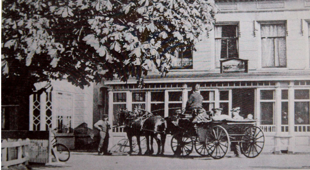
Afb. 2 Hotel Hamdorff, het hotel van Wouter Hamdorff's oom te Laren. Foto: Laren Rijk aan Monumenten .
