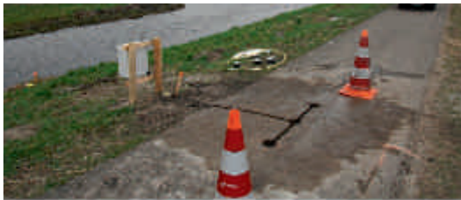
Installatie waterspanningsmeters.
