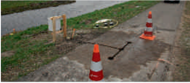
Installatie waterspanningsmeters.
