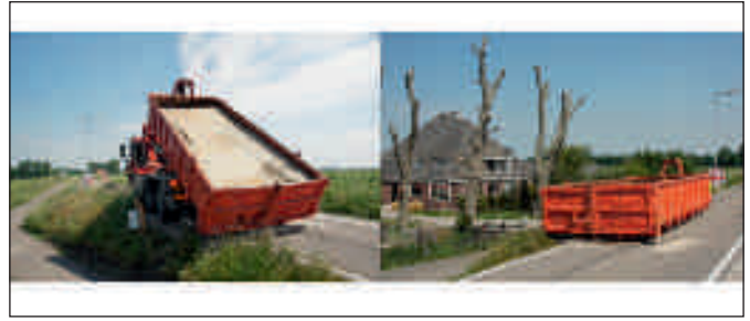
Aangebrachte belasting langs Starnmeerdijk.
