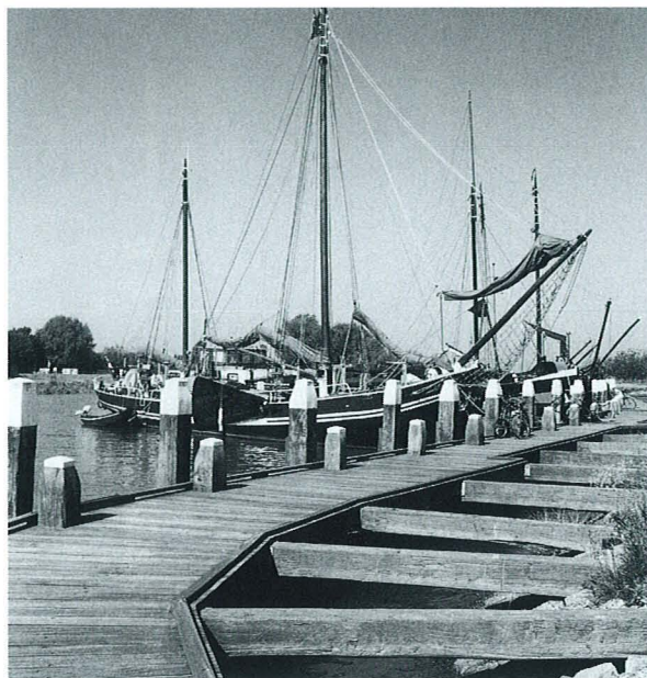
Haven van Woudrichem, steiger van hergebruikt en nieuw hout
