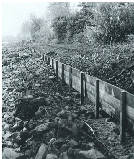
Oeverbeschoeiing in aanleg
