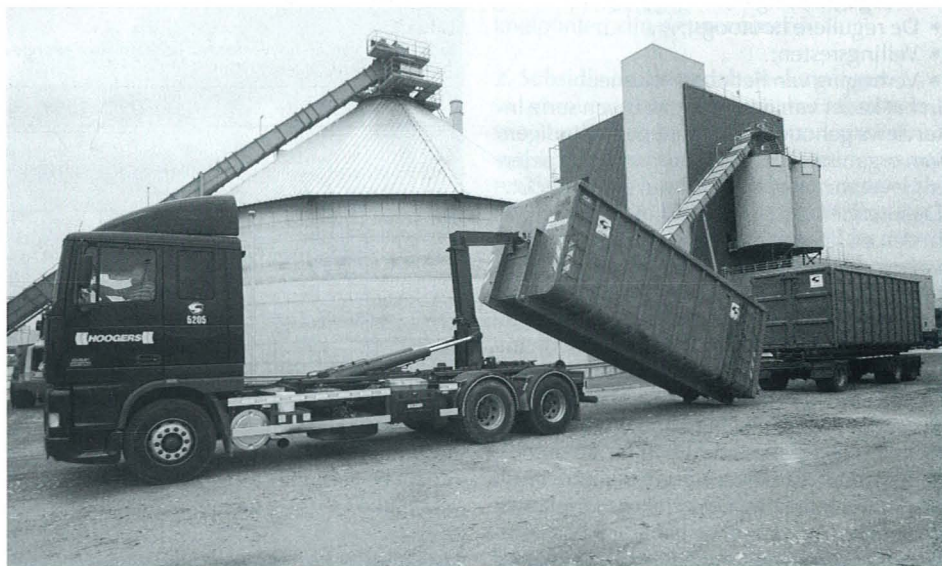
Energiehoutchips wordt in containers afgeleverd bij de energiecentrale
