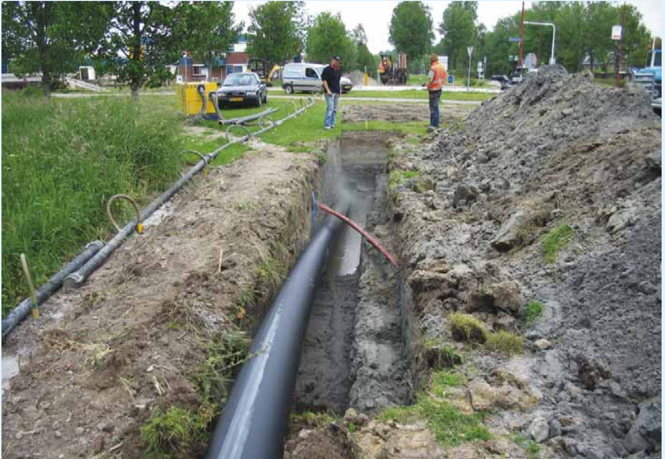
De aanleg afgelopen najaar van de persleiding tussen de hoofdrioolgemalen Beveland en Zandhorst in Heerhugowaard.
