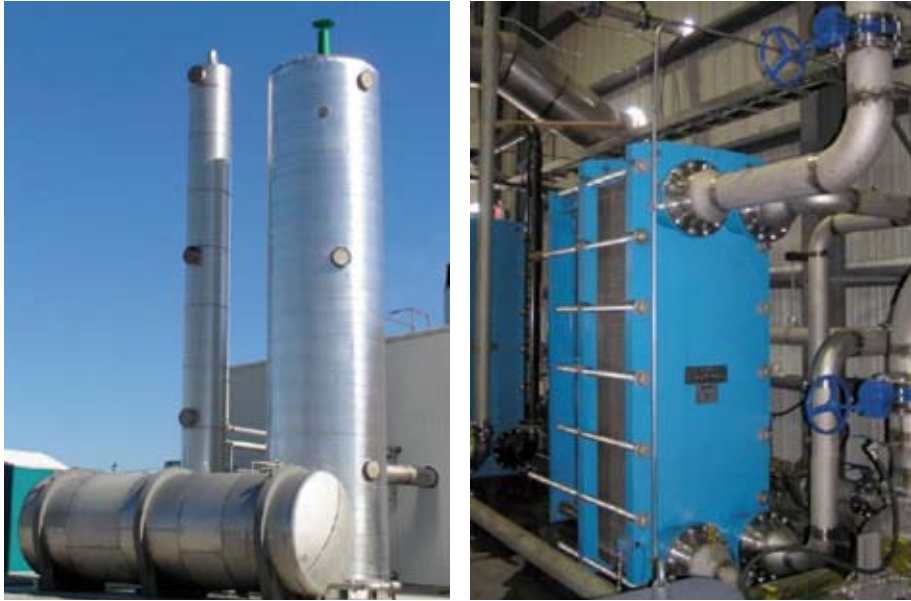
Foto 12: CO 2 -absorptie uit rookgashoutketel bij glastuinder in Canada (Procédé).
