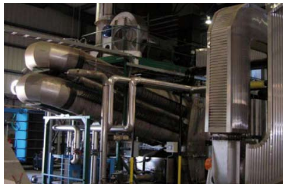
Foto 11: Rookgasreiniging houtketel bij glastuinder in Canada (Procédé).
