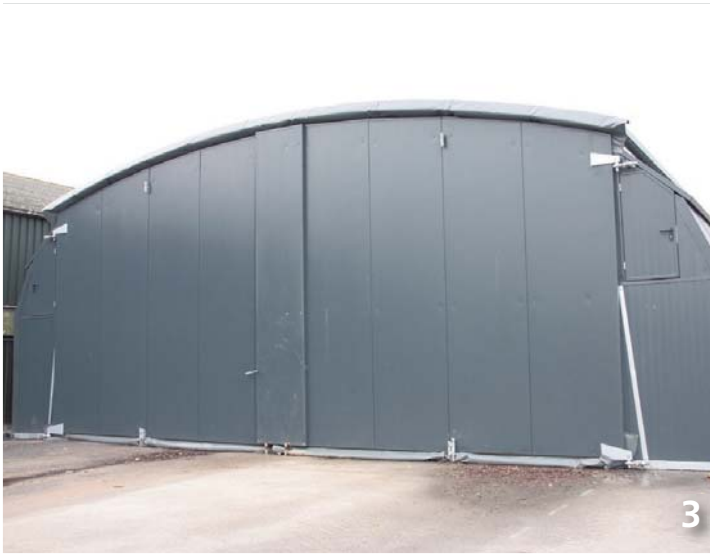
1: Een los element is van onderen 1 meter breed en voorzien van een 20 centimeter dikke betonnen plaat. De lengte is 6 meter, de hoogte is 4.20 meter. De elementen worden los op de ondergrond gezet. 2: De MDI is in gebruik. Aan de zijkant zitten de profielen vast met kettingen. Die zorgen ervoor dat de wanden niet wegschuiven en bevorderen een gelijke luchtverdeling door de partij. 03: De deuren zijn gewone openslaande deuren. Rondom op de grond liggen rubberen flappen om de zaak vorstvrij te houden. 04: De geïntegreerde aansturingkast is helemaal compleet. Alleen de stroom ernaar toe moet de teler zelf regelen. Een set trekt 10A. De ventilatoren gebruiken 4A.
