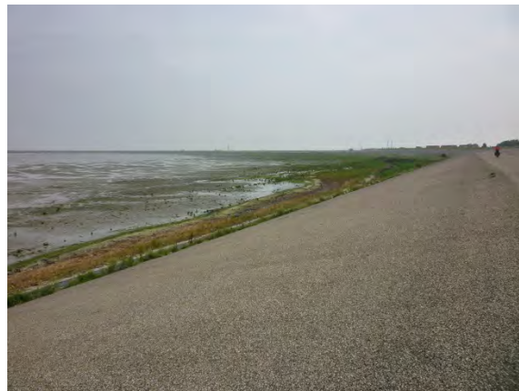
Waddendijk bij Den Oever (asfalt bekleding en kwelder)
