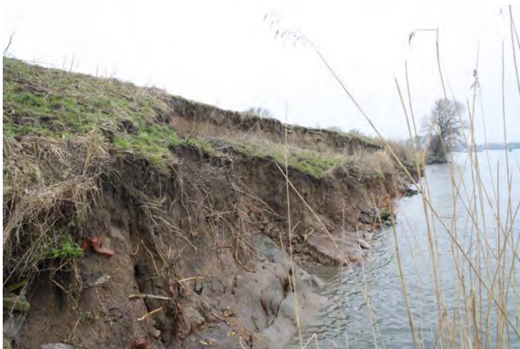
Figuur 17 Afschuiving vooroever van een rivierdijk langs de Oude Maas.
