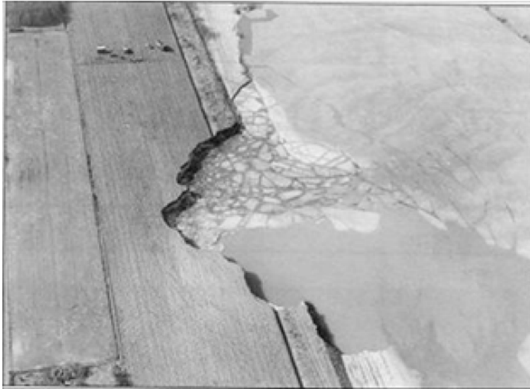
Figuur 19 Zettingsvloeiing.
