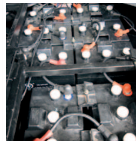
▲ De negen onderhoudsvrije accu's van elk 8 volt bevinden zich onder de stoelzittingen.
