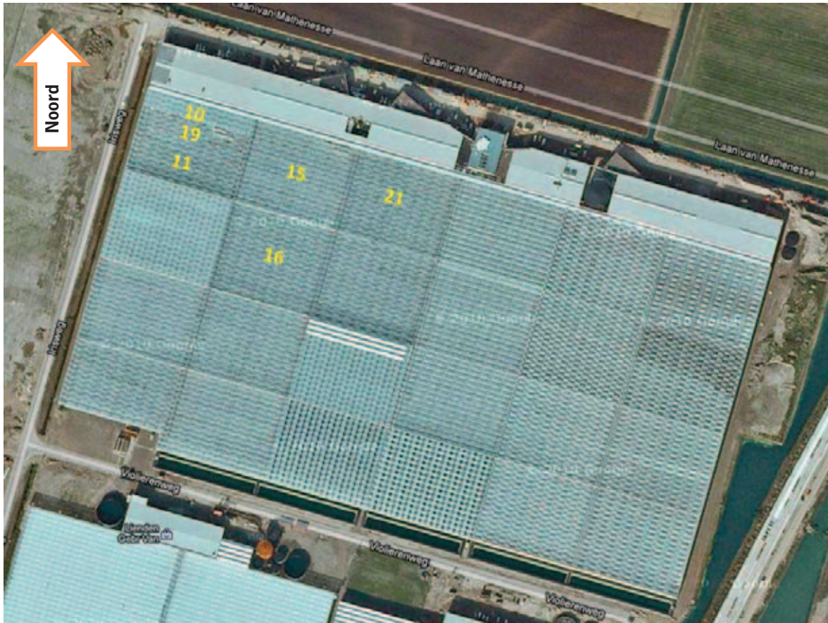
Figuur 1. Snapshot (Google Maps) van Plantenkwekerij Van der Lugt met afdeling 15 en aanliggende afdelingen.
