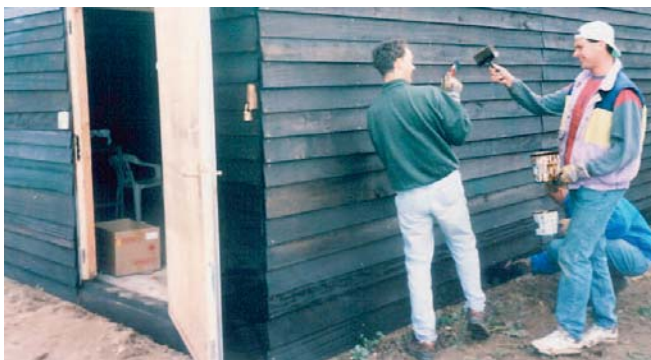
Het gebouw is geschilderd, de grappen komen los, de spanning valt weg.
