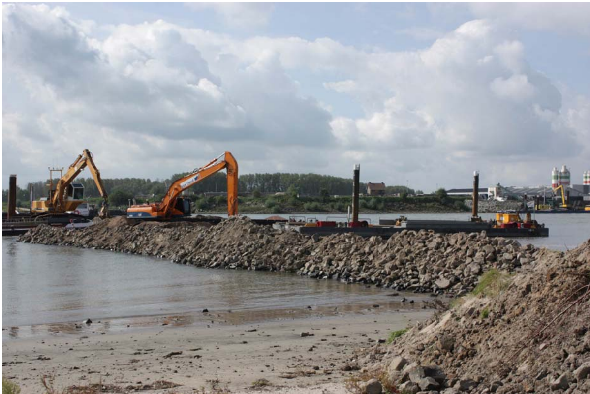
Afbeelding 1. De aanleg van een verlaagde krib
