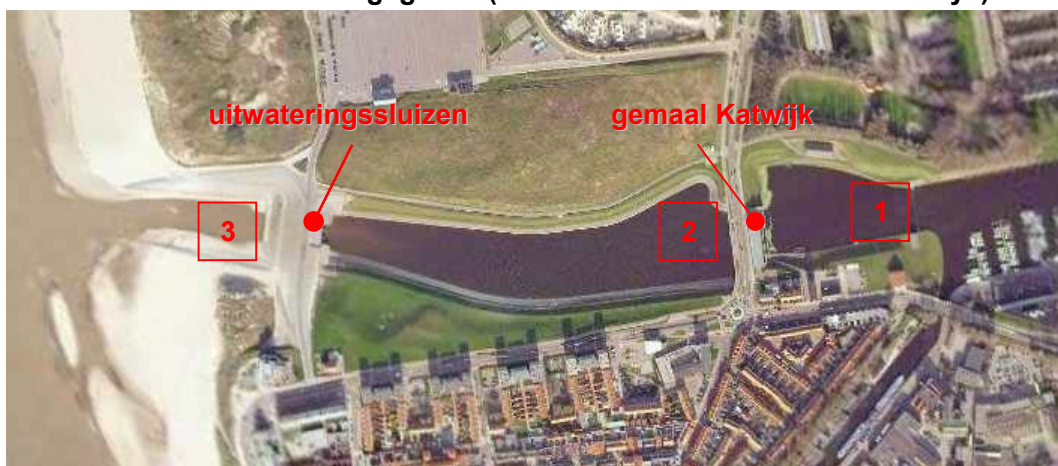
Afbeelding 3.1. Bovenaanzicht van het complex van gemaal Katwijk en de bijbehorende uitwateringssluizen. Met cijfers zijn de locaties voor bovenbeschreven deelonderzoeken weergegeven (foto: Aerodata International Surveys)
