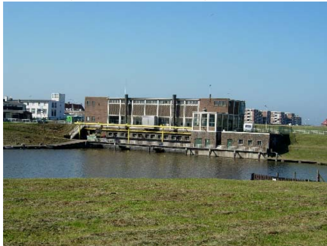
Afbeelding 1.2. Aanzicht van gemaal Katwijk aan de zeezijde
