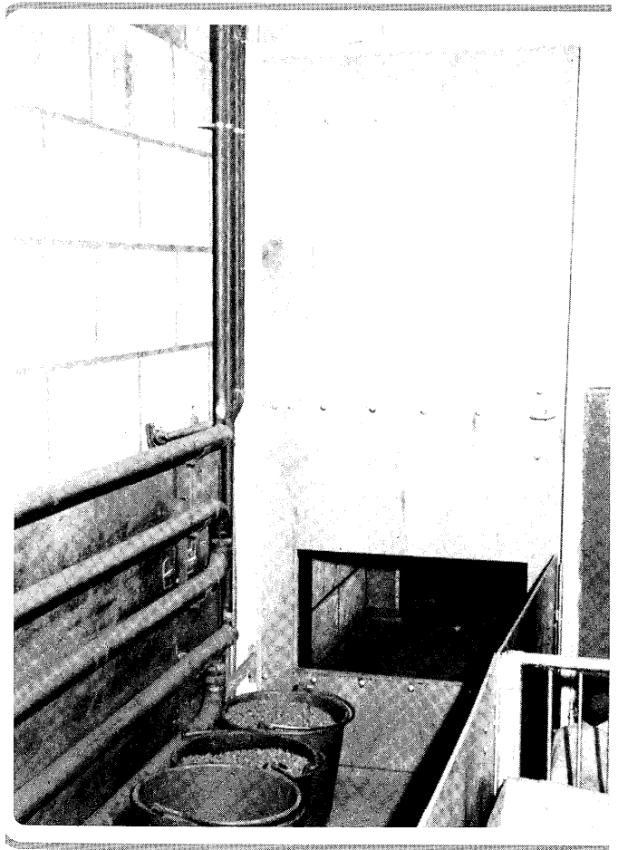
Deurventilatie gespeende biggen
