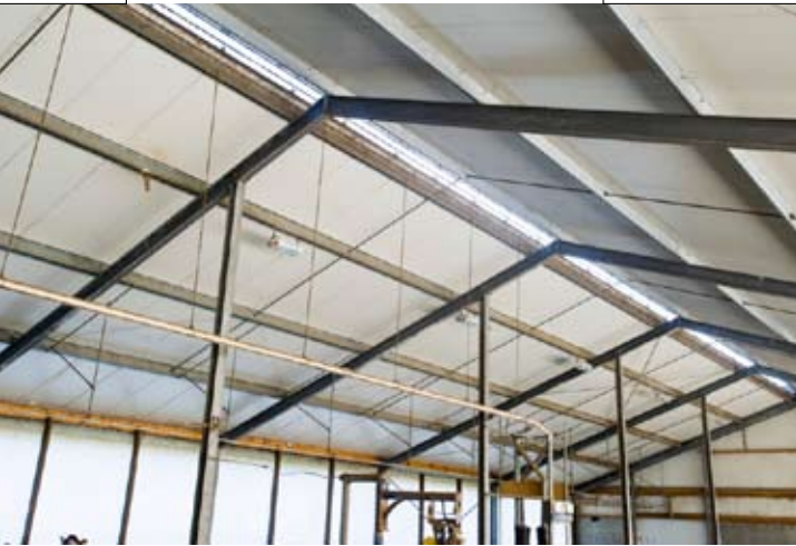
De nieuwe stal heeft een geïsoleerd dak
