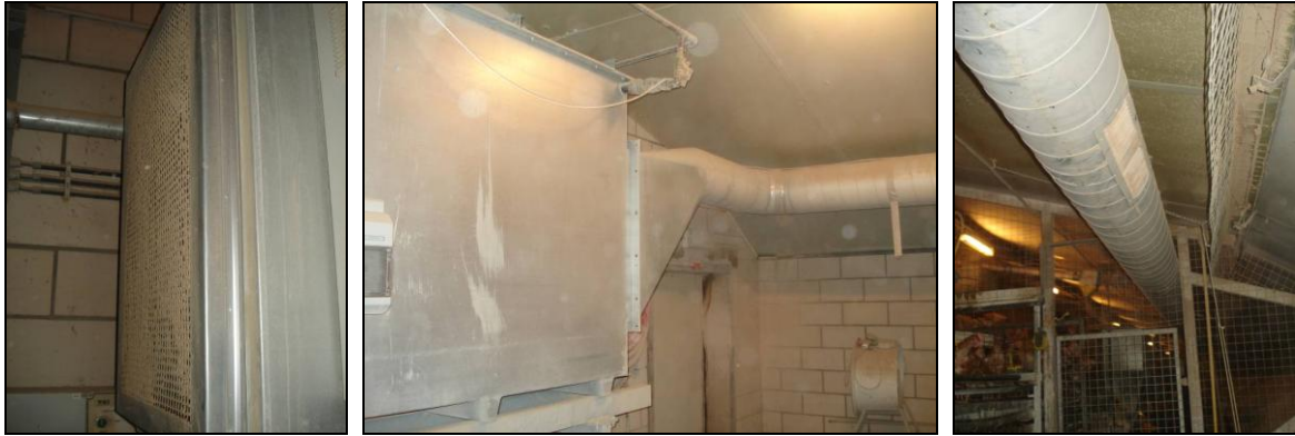
Figuur 3 Links: instroomopening van de vuile lucht van het systeem. Midden: recirculatiesysteem met ionisatiefilter met rechts het luchtkanaal dat naar de stal gaat. Rechts: luchtkanaal in de afdeling met een uitstroomopening
