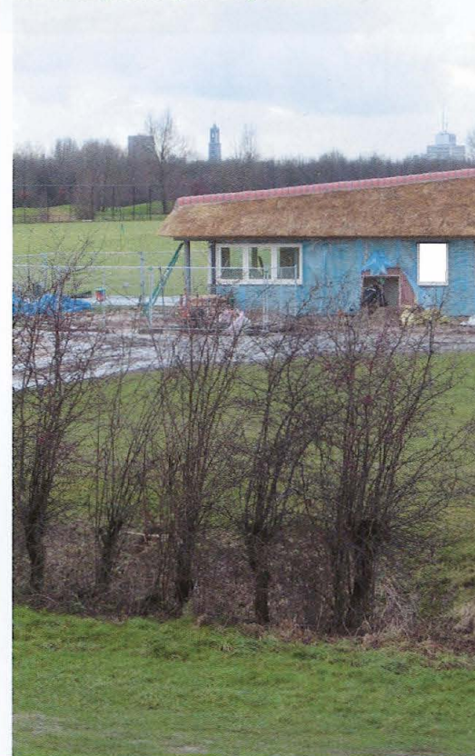
Domtoren op de achtergrond en het nieuwe gebouw op de voorgrond
