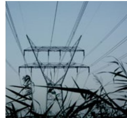
▲ Blindstroom kost transportruimte bij de netbeheerder.
