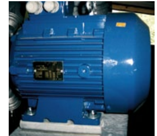
▲ Op het typeplaatje van een elektromotor staat de cos phi vermeld.
