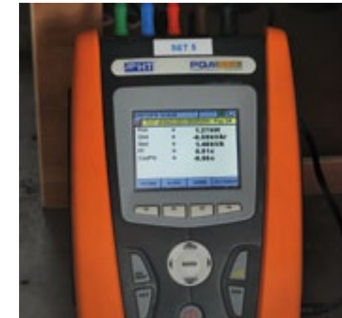
▲ Meting van een zeer slechte cosinus phi (cos φ): de hoeveelheid onbenut vermogen.
