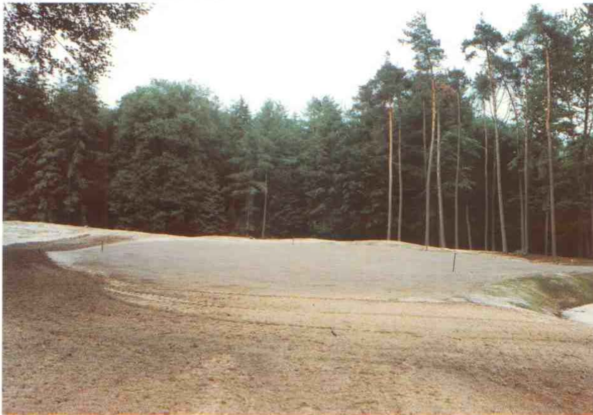
Geprofileerde top laag op green 8, markeringen ter plaatse van sproeiers
