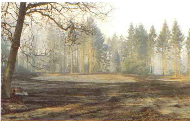
Geprofileerde onderbouw van green 10, voor drainag
