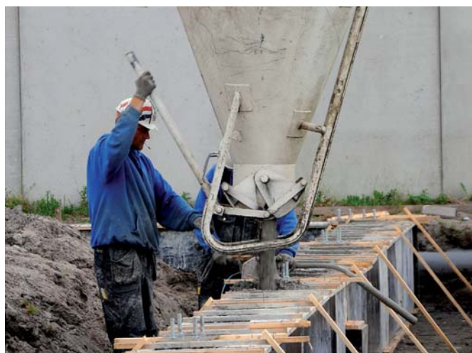
Betonstorten voor de fundering
