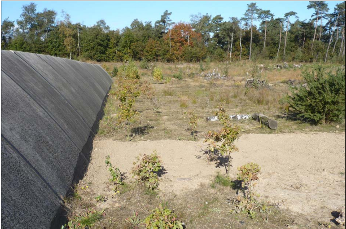
Een sporenbed op Ecoduct Leusderheide over rijksweg A28. Het sporenbed is strak tegen de zijkanten van het ecoduct aangelegd, zodat ook soorten worden geregistreerd die bij voorkeur langs de randen van het ecoduct passeren (© E. van der Grift).
