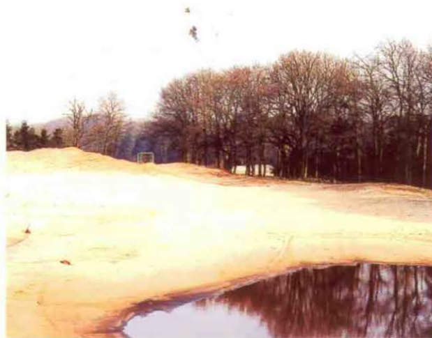
Op de Lage Vuursche wordt met een gesloten grondbalans gewerkt van zo'n 40.000 m3 zand. Alleen voor de randen van de vijvers wordt van elders klei aangevoerd.
