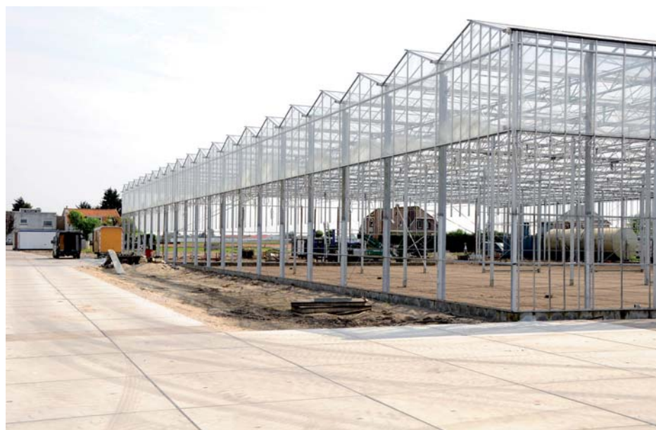
Naast het bedrijf komen in totaal drie dockshelters
