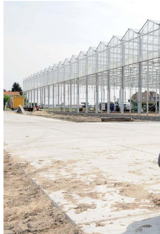
Jaco Leenen in de nieuwbouw
