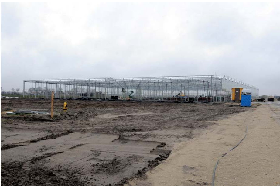
Een deel van de kas is gesloopt
