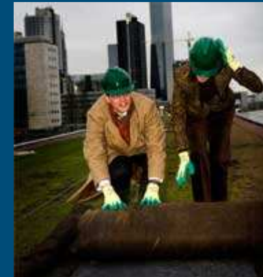
“Groen dak Erasmus ziekenhuis Rotterdam”
