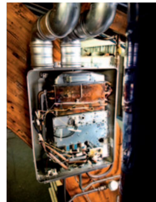
Het binnenwerk van de Rinnai HD70i. Bovenin, onder de koperkleurige kap, de warmtewisselaar.
