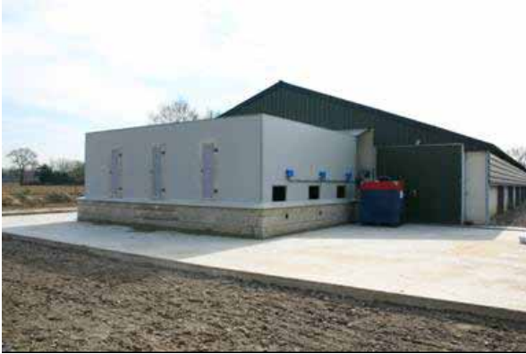
Chemische wasser achter de vleeskuikensouderdierenstal en de uitstroomopening van de uitgaande gewassen lucht
