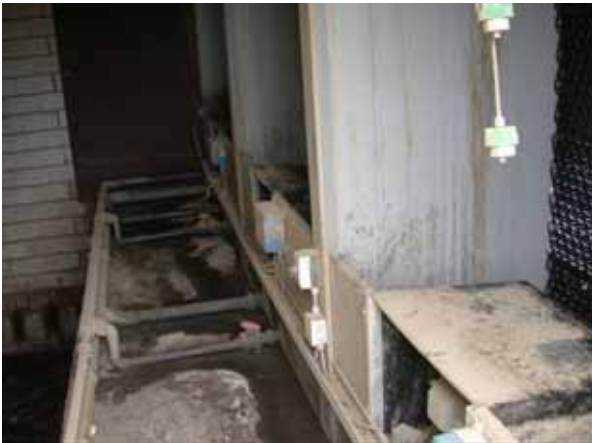
Situatie van de ingaande lucht van een chemische wasser bij het module concept en de openingen voor uitgaande lucht bij een zijwaartse uitstroming
