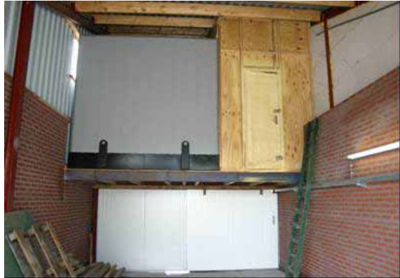
Centrale mengtank en chemische wasser met daarvoor de drukkamer (hout)
