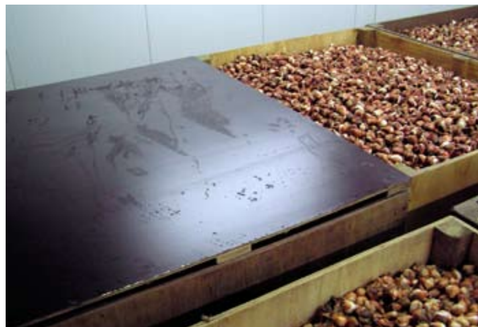
Door afdekking van de bovenste kist kan de luchtverdeling over de kisten sterk verbeterd worden
